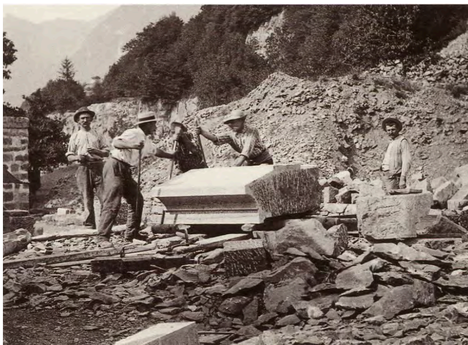
Fig. 30 - Élément en pierre pour le pont de la Coulouvrenière de Genève, 1895.
