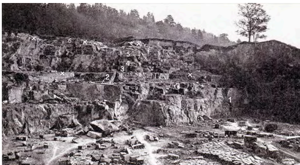
Fig. 21 - Exploitation de la carrière des Andonces (dite aussi Etrives) vers 1905. Au milieu (2), le banc dit «des bassins».
