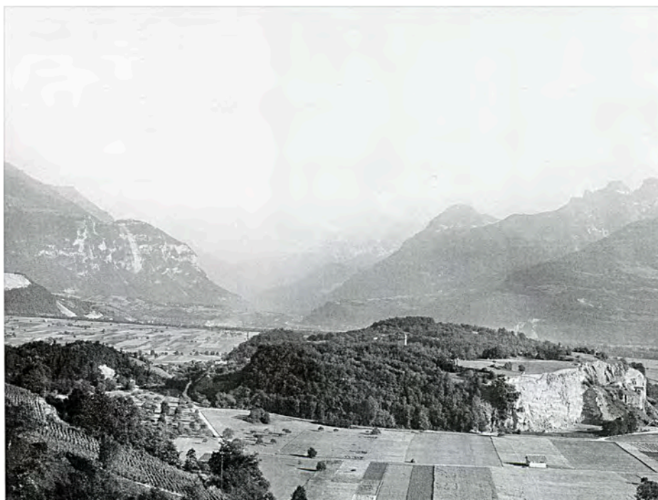
Fig. 4. 77 - Vue du Lessus depuis Plantour
