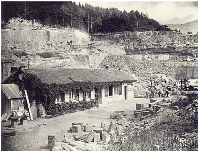
Fig. 12 - Les bureaux de la carrière des Etrives en 1892 avec quelques pièces terminées en dépôt
