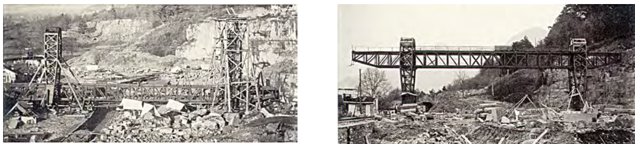
Figs. 15 et 16 - Mise en place du bras
