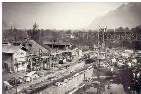
Fig. 19 - Vue du chantier ouest avec les débiteuses au fil.
