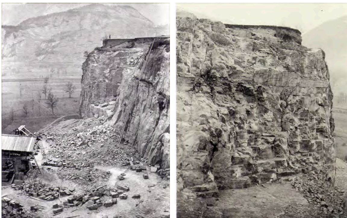
Fig. 27 et 28 - Au Lessus en 1895, fronts de taille ouest et est.
