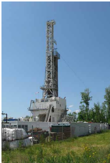
Tour de forage à Noville. Durant l'année 2010, elle a dominé la plaine du Rhône de ses 65 mètres.
